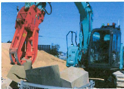
建設機械(遠隔操作) 危険エリアでの作業を、遠隔地から安全に実施
