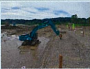
遠隔施工状況
