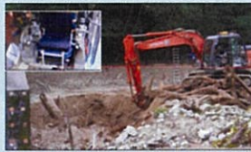
無人バックホウ稼働状況
