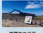
遠隔施工状況
