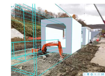
掘削作業時にARと比較
