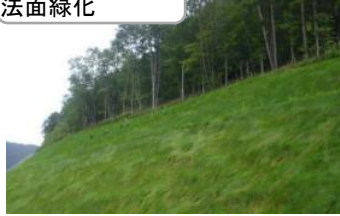
富士見工業・ ウッディソイル・ネオ工法
