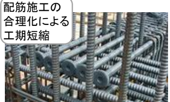
清水建設・Tヘッド工法鉄筋
