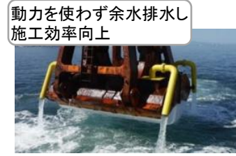
東洋建設・ サイホン式余水排水工法
