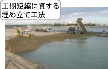
日本国土開発・ 事前混合処理工法 (PREM工法)
