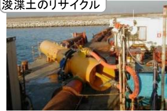
あおみ建設・K-DPM工法
