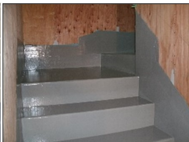
写真 1.2.2 屋外階段の 塗膜防水施工の事例
