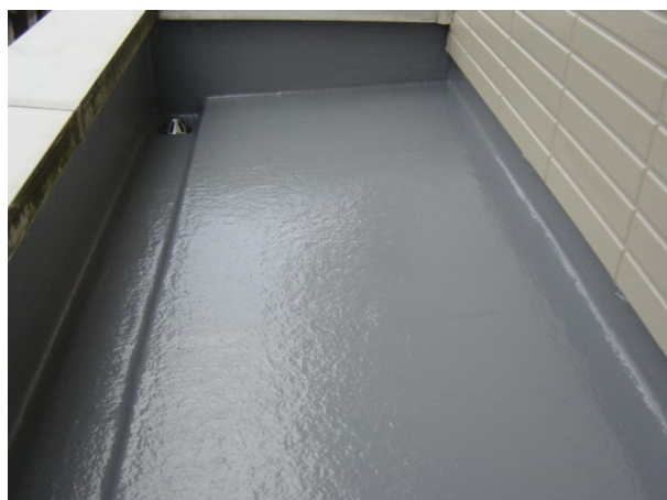
写真 1.2.1 FRP系塗膜防水の 施工の事例
