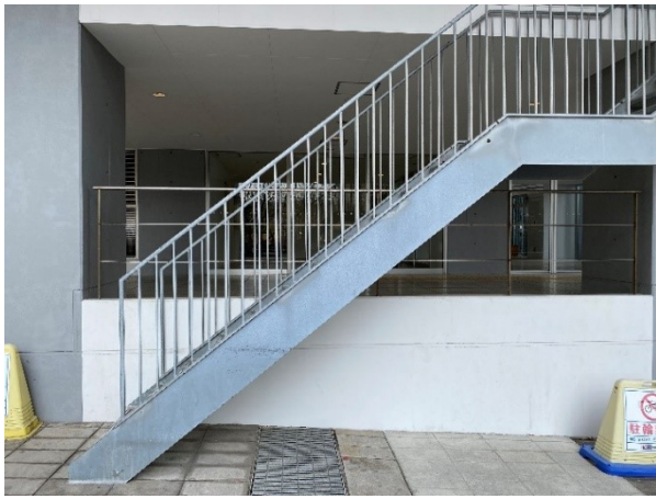
写真 1.3.4 塗料による防錆措置の事例
