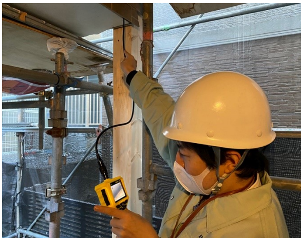
写真 2.2.1 ファイバースコープを使った点検の例
