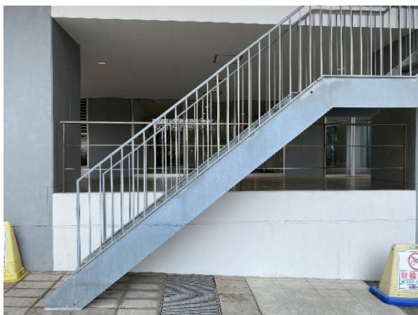
写真 1.3.4 塗料による防錆措置の事例
