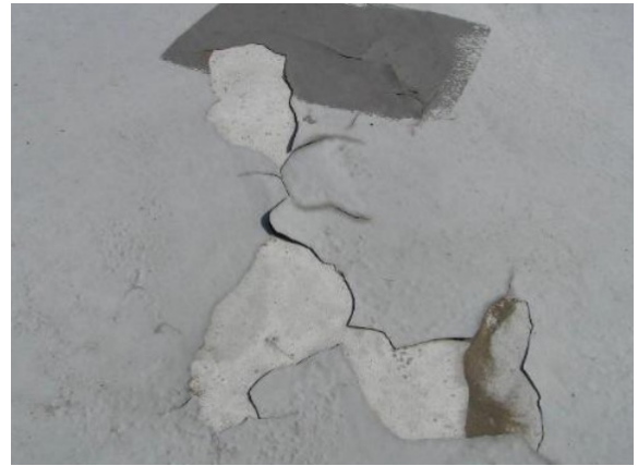
写真 2.1.2 防水層の破損の事例
