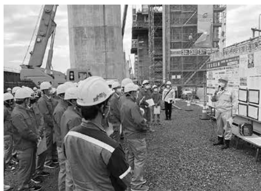
新名神の高架橋工事(城陽市)を見学する工学院高校生の皆さん
