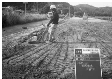
国道175号線の路床盛土工事を行う三浦さん
