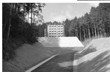
京北中部簡易水道整備(その18)工事
