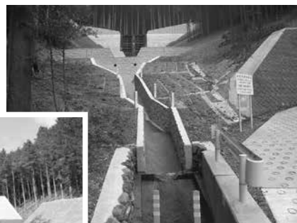
水尾川通常砂防(防災安全)工事
