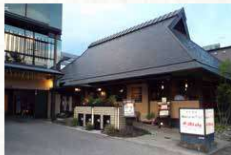
古民家を移築してつくられた南山本店
