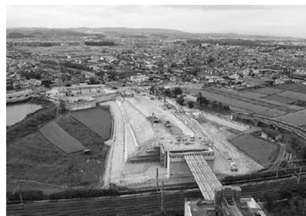
木津東バイパス木津地区改良工事
