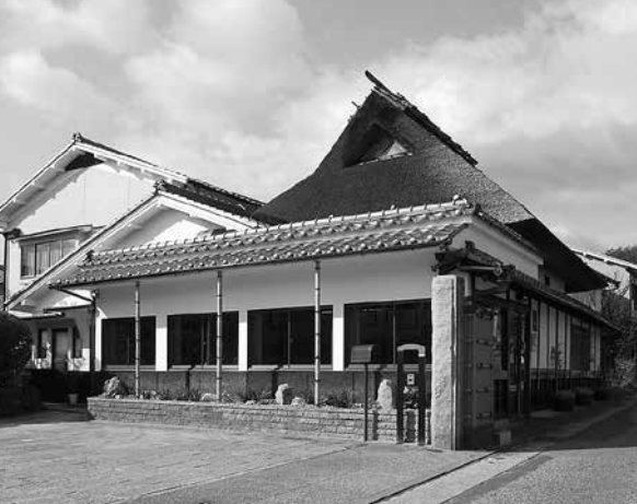
吉川組本社社屋の茅葺屋根
