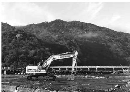
桂川嵐山地区6号井堰撤去工事
