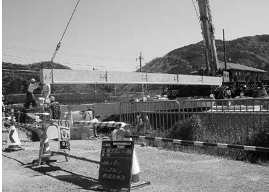
建設中の北古世西川橋
