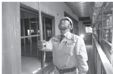
施工状況を確認する藤本さん
