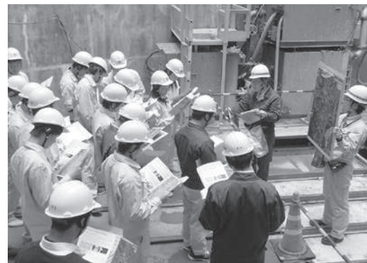
シールド工法の説明を受ける伏工高生
