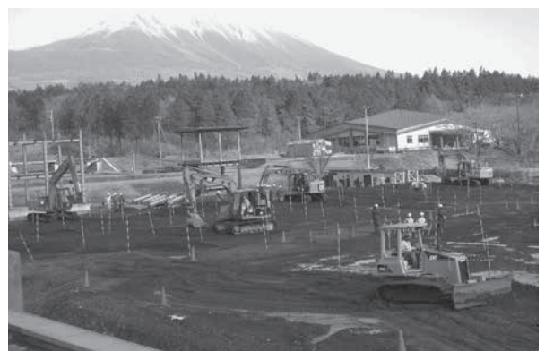
広いフィールドで行われる建設機械運転実習
