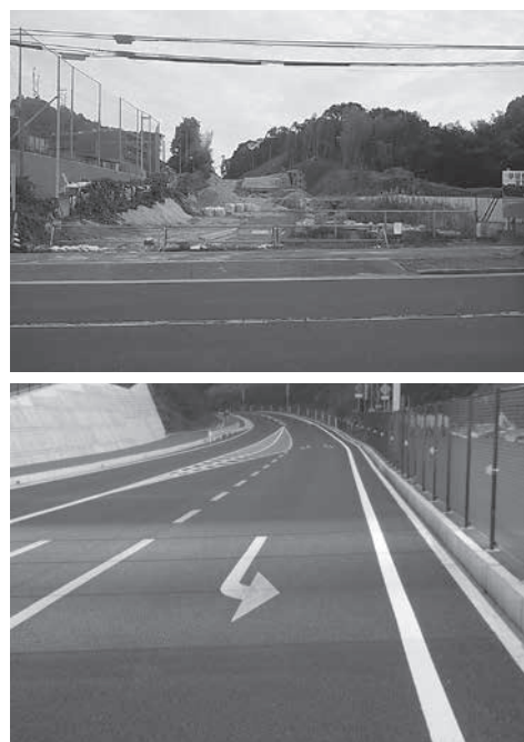
八幡木津線の着工前（上）と竣工後（下）の様子
