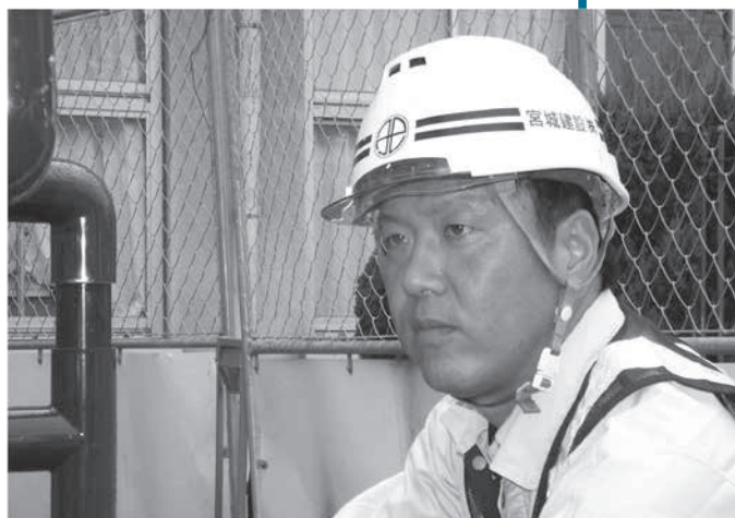
受水槽改修の配管工事をする葛輪正人さん
