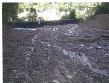
写真4 大型の台風18号による土砂崩れを下段の仮堰堤で食い止める
