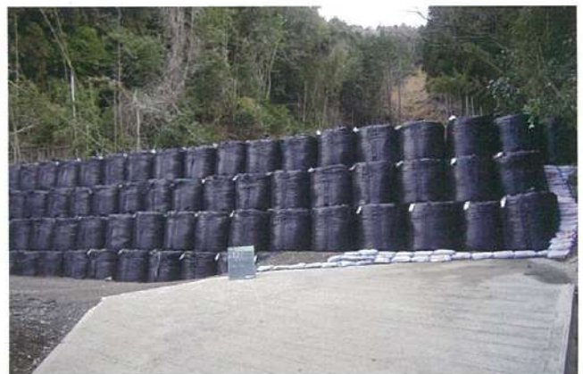
写真4 大型の台風18号による土砂崩れを下段の仮堰堤で食い止める
